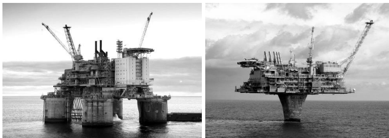
Рис. 1. Нефтяные платформы на железобетонных опорах
